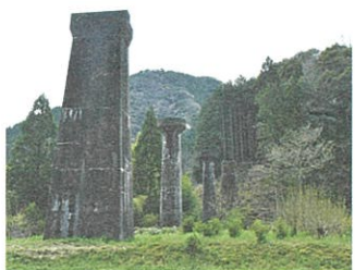
完成することなく工事が中止された広島と浜田を結ぶ鉄道跡
